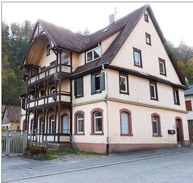
Das ehemalige Lehrerwohngebäude in der Wasserfallstraße ist nach Auskunft von Bürgermeisters Acker zu marode, um es zu erhalten. Foto: Danner
